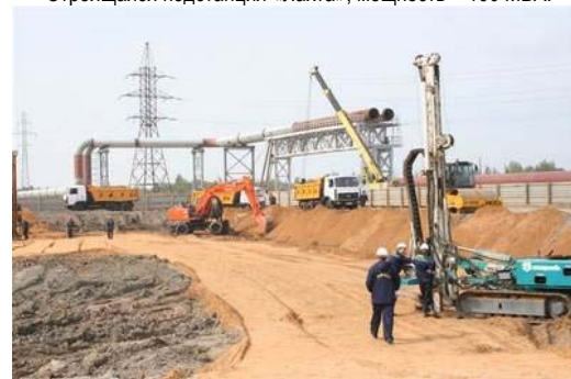
Строящаяся подстанция «Лахта», мощность – 160 МВА.
